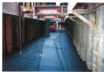
透過反応壁設置状況
