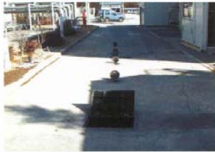
現場実施状況
